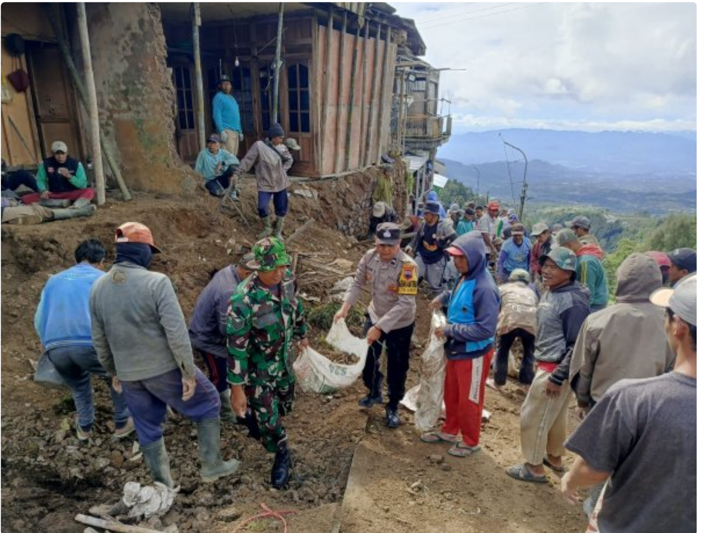
(Foto Dokumen) : Gotong royong pembersihan material longsor
